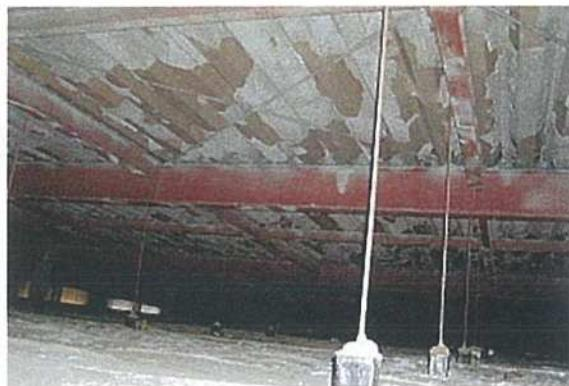
写真の状況：折板屋根において、気温や風圧による折板屋根の収縮や振動での脱落が見られる。
