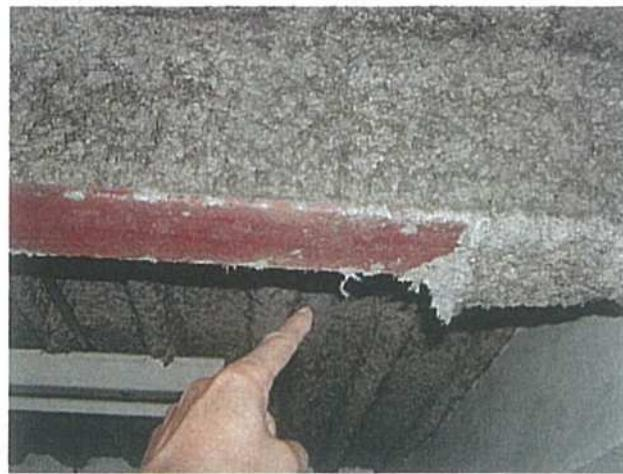
写真の状況：吹き放し工法であり、セメントスラリーもなく脱落箇所がある。
